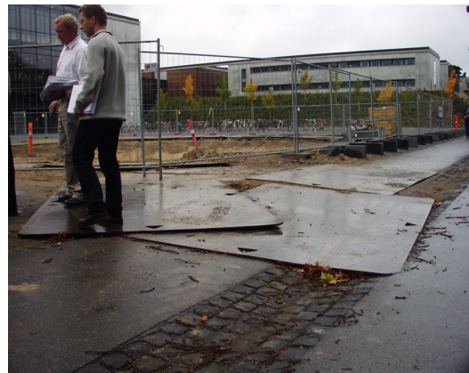
2. Udgravning ved hovedindgangen
