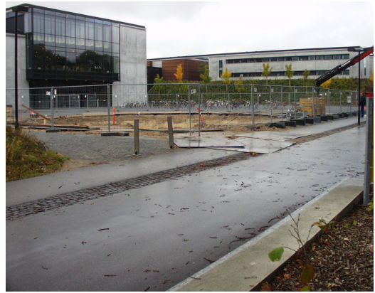
1. Udgravning ved hovedindgangen
